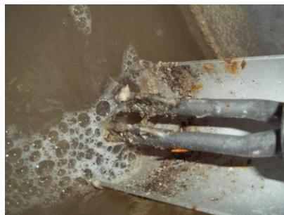
Fig. 30 Sonde de vibration limite obstruée
