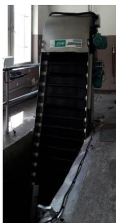
Fig. 3 Dégrilleur vertical dans le canal
