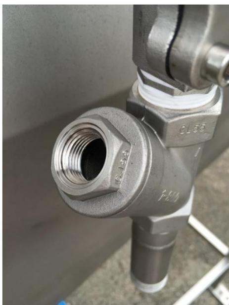
Fig. 35 Nettoyage du filtre des conduits
