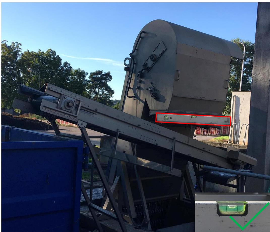
Fig. 19 Contrôle de la position horizontale du dispositif (à côté de la trémie)
